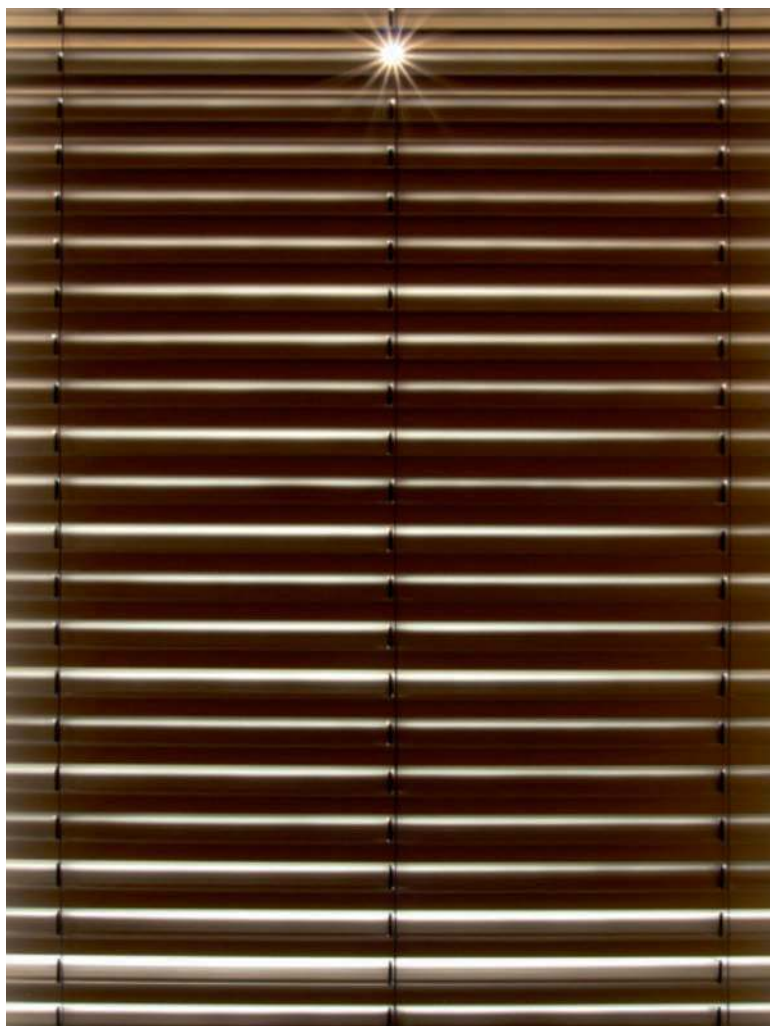
Bild 5. Variabler Streulichteintrag (Ansicht von innen)
