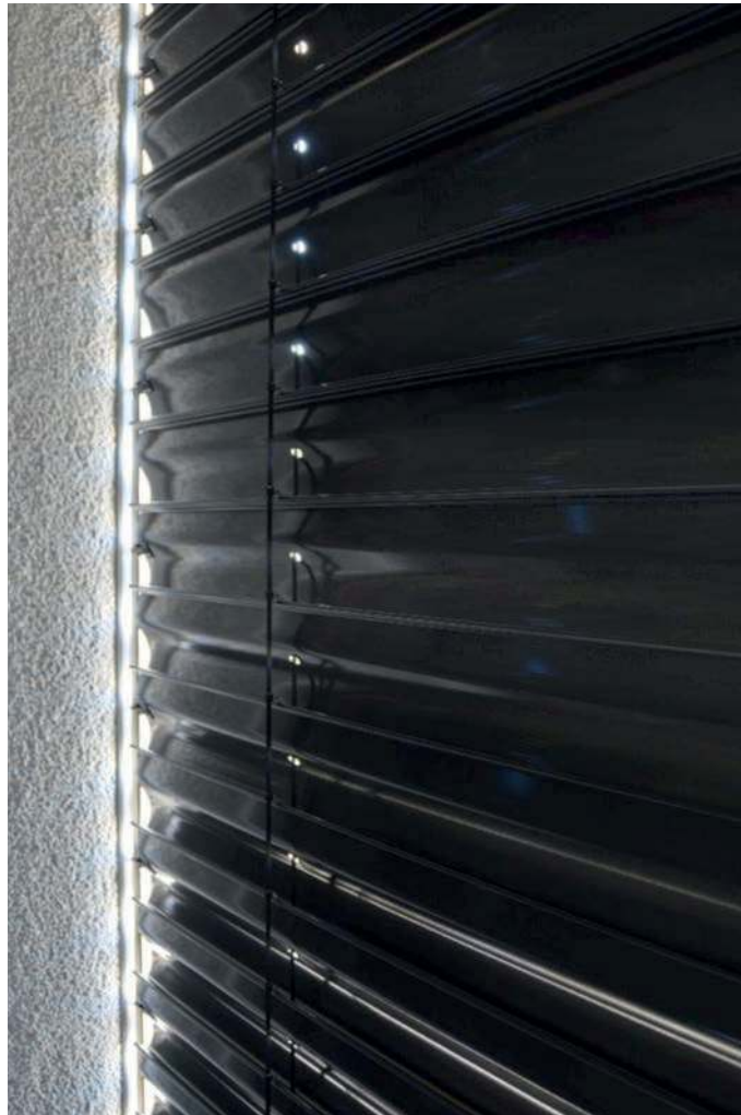
Bild 4. Zulässiger Streulichteinfall über die seitliche Führung
